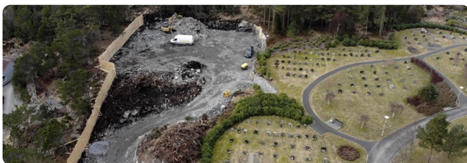
Arbeidet med Tveit parkeringsplass skal etter planen være ferdig i løpet av april måned.
