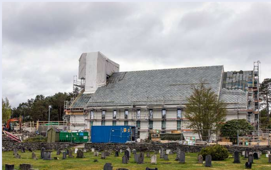
Nye Tveit kirke begynner å ta form. Arbeidet er i rute, og kirken skal være klar til vigslingsgudstjenesten 20. august. Foto: Håkon Andersen
